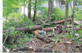
Eliminación de material combustible. (NPS / Fred Mason)
